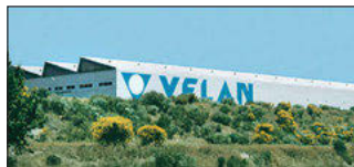
Lisbon, Portugal Velan Válvulas Industriais, Lda.
